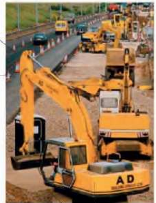
замена дорожного покрытия zamena dorozhnogo pokrytiya resurfacing
